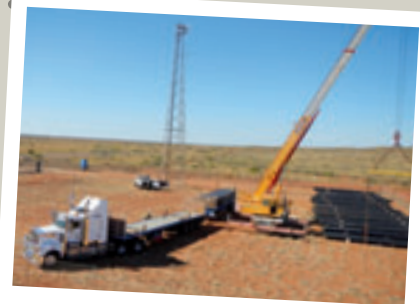
8. Australien Rohr-Anlieferung und Abstapelung für die Ashburton Onslow Gas Pipeline
