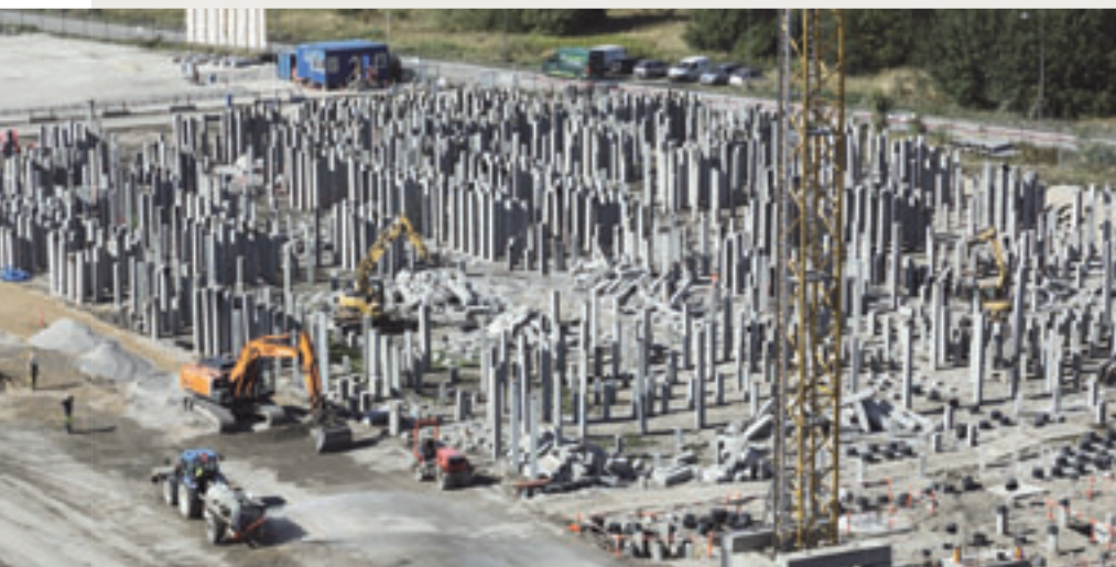
Links: Beginn der Fundamentarbeiten für die neue Anlage, die mit 100 m Höhe eine neue Landmarke für Kopenhagen werden soll.
