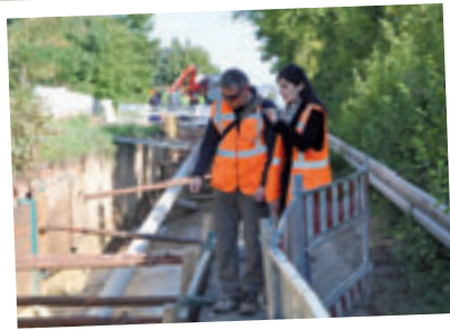
1. Deutschland Besichtigung einer Baustelle der Stadtwerke Mainz
