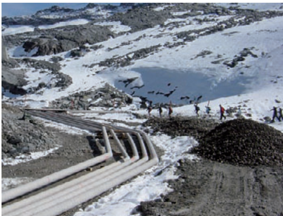
Die Beschneigungsabschnitte werden über mehrere Kompressorstationen versorgt. Dies machte die Verlegung separater Versorgungsleitungen erforderlich.
