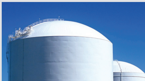
Bild 1: Onshore LNG-Tanks aus Tiefsttemperaturstahl [1]
