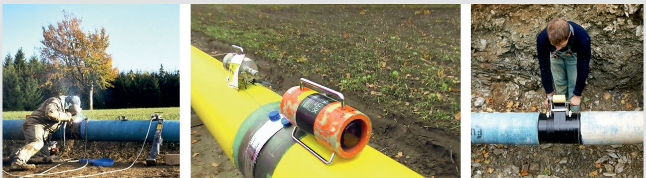
Bild 1: Schweißen – Prüfen – Nachumhüllen
