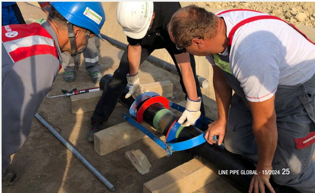
Einsatz der Rohrreinzugsvorrichtung.
