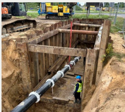
Vorbereitung für eine Straßenunterquerung.
