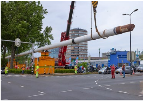
Die Verlegearbeiten mit den langen Rohrsträngen sorgten stets für großes Interesse.
