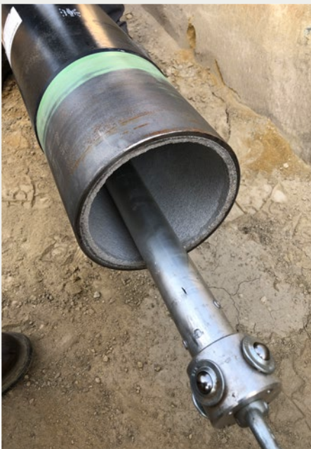
Lanze der Molchvorrichtung für die Rohrverbindungsstellen.
