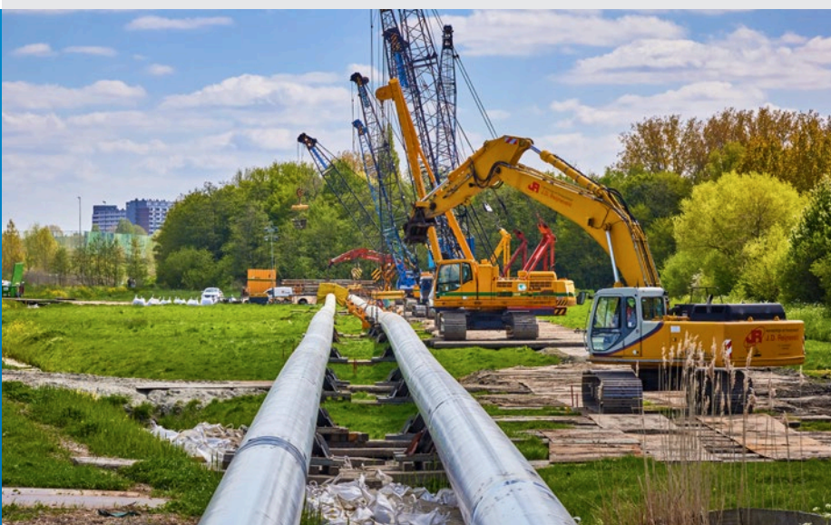
Auch in den Niederlanden wird der Ausbau von Fernwärmenetzen vorangetrieben. Für das Projekt »WarmtelinQ« lieferte Mannesmann Line Pipe 600 Tonnen HFI-geschweißte Stahlrohre. Foto: © WarmtelinQ, Vincent Basler
