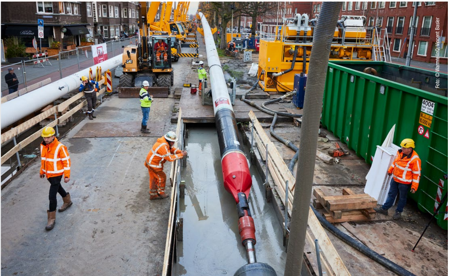
Wann immer möglich, wurden die Fernwärmerohre zu langen Strängen verbunden und umweltverträglich grabenlos eingezogen.
