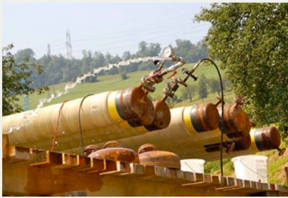
Die an Land zusammengeschweißten Rohrstränge wurden einer Druckprüfung mit 7,5 bar unterzogen.
