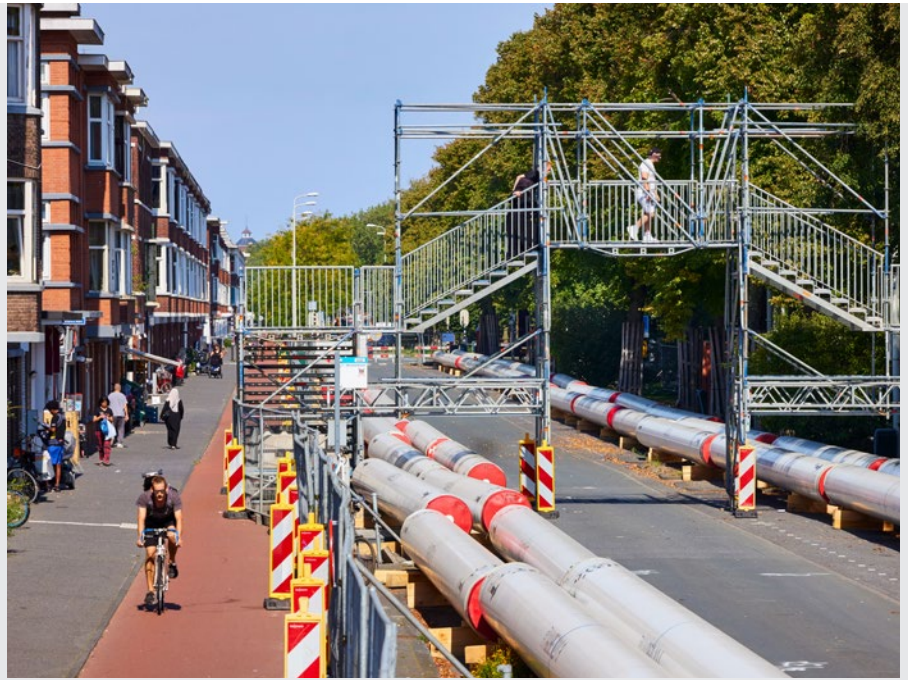
Die Bauarbeiten zu »WarmtelinQ« erfolgten an bis zu 30 Stellen gleichzeitig. Foto: © WarmtelinQ, Vincent Basler
